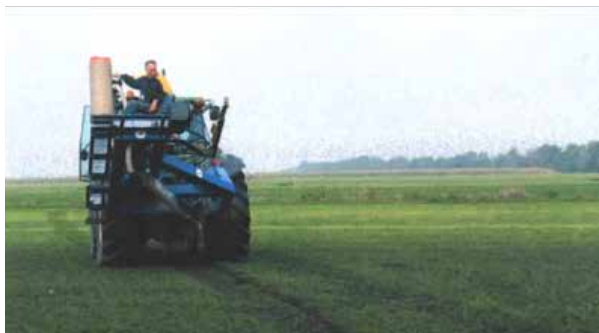
Aanleg sleufloze drainage
