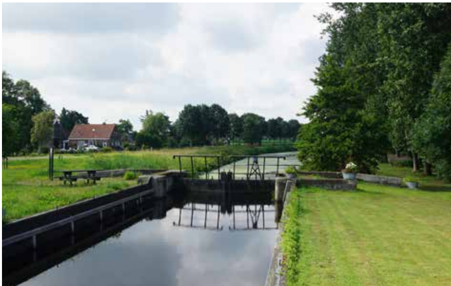
De gerestaureerde Grachtsluis
