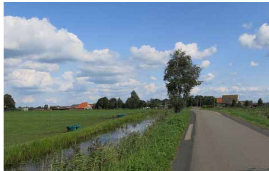
Hoogwatervoorzieningen langs wegen
