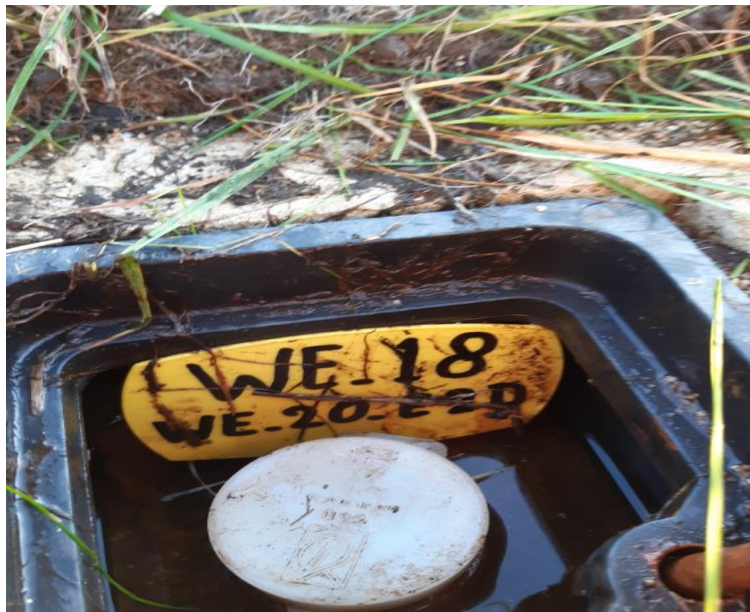
Figuur 19. Grondwaterstandbuis met afgesloten dop. Buizen zonder loggers worden niet afgesloten
