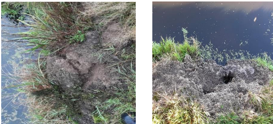
Figuur 4-13. Afkalving door de droogte. Links de vorming en afglijden van brokken bij kleilig veen en rechts de vorming van hydrofoob poederig veen op de oever.
