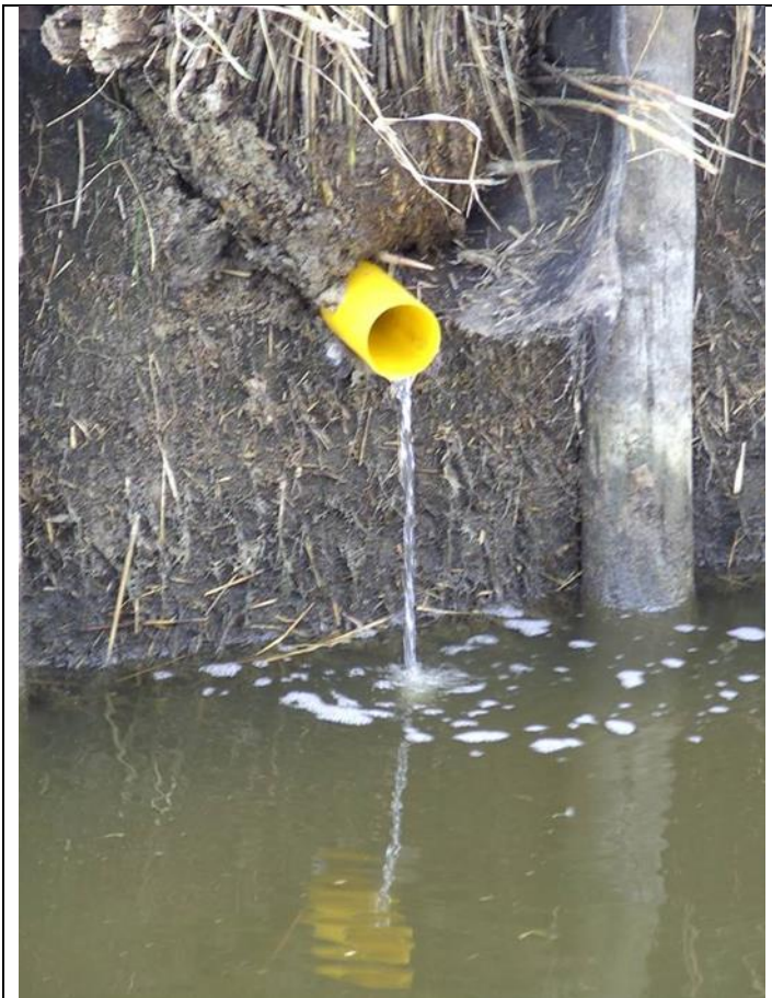
Uitmonding van de drain. Maak deze elk najaar vrij, zodat de buis goed kan blijven stromen
