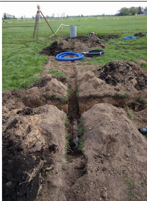
Aanleg van gecombineerd drainage systeem welke uitstroomt op een put. In de put kan het peil geregeld worden (zogenaamde drukdrainage)
