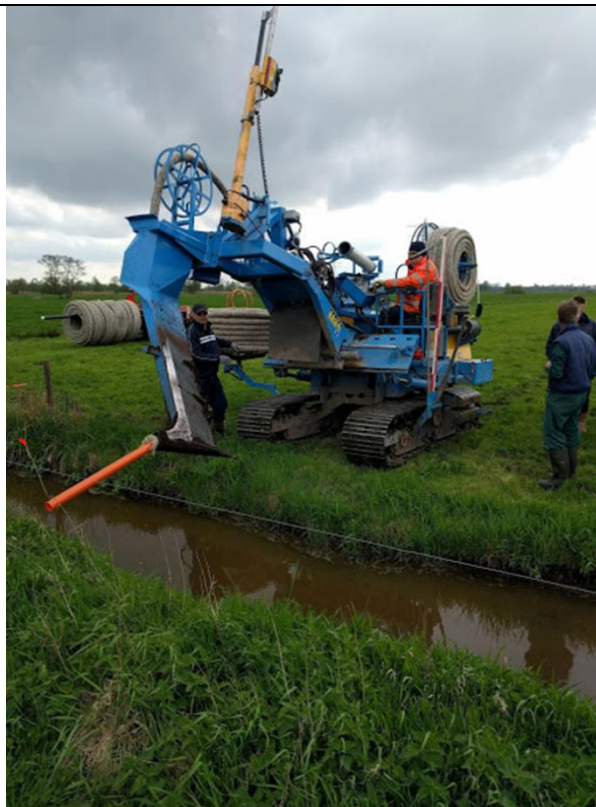
Aanleg van onderwaterdrainage
