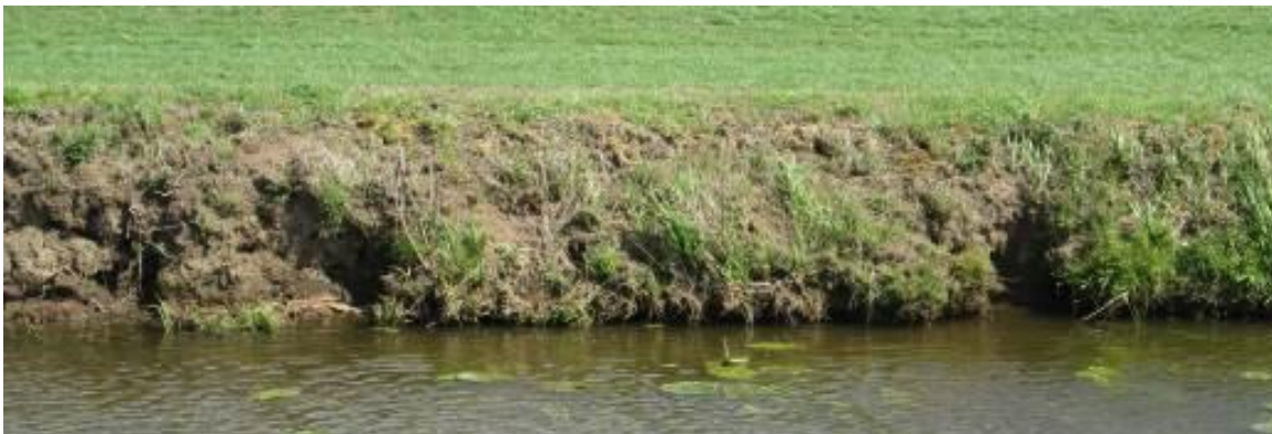
Het buitentalud van de kering in Pikesyl is behoorlijk aangetast door muizen. In dit soort slootkanten in Fryslân zijn ook altijd Woelratten aan te treffen. Navraag bij Muskusrattenvangers leerde dat er wel meer Woelratten werden aangetroffen dan in andere jaren, maar niet extreem veel.
