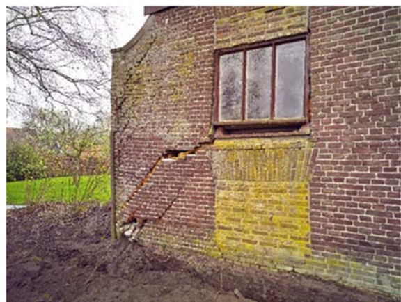
Funderingswerk Friese Boerderij
